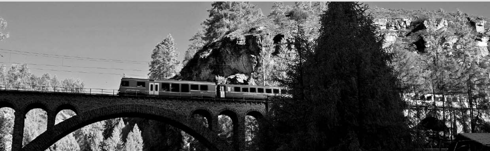
Die Rhätische Bahn auf dem Val Tuoi-Viadukt bei Garsun
