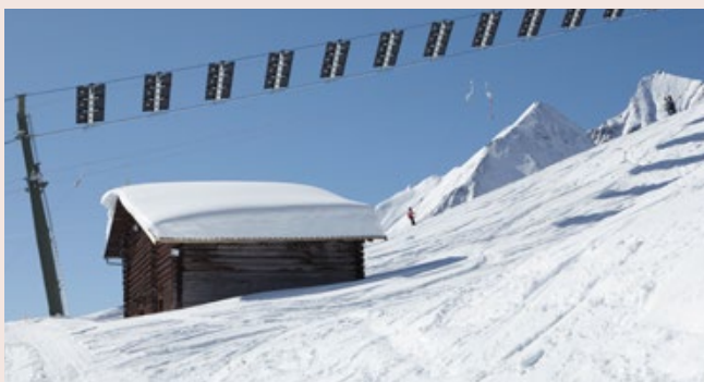
Abb. 16: Solar-Skilift in Tenna (Gemeinde Safiental)
